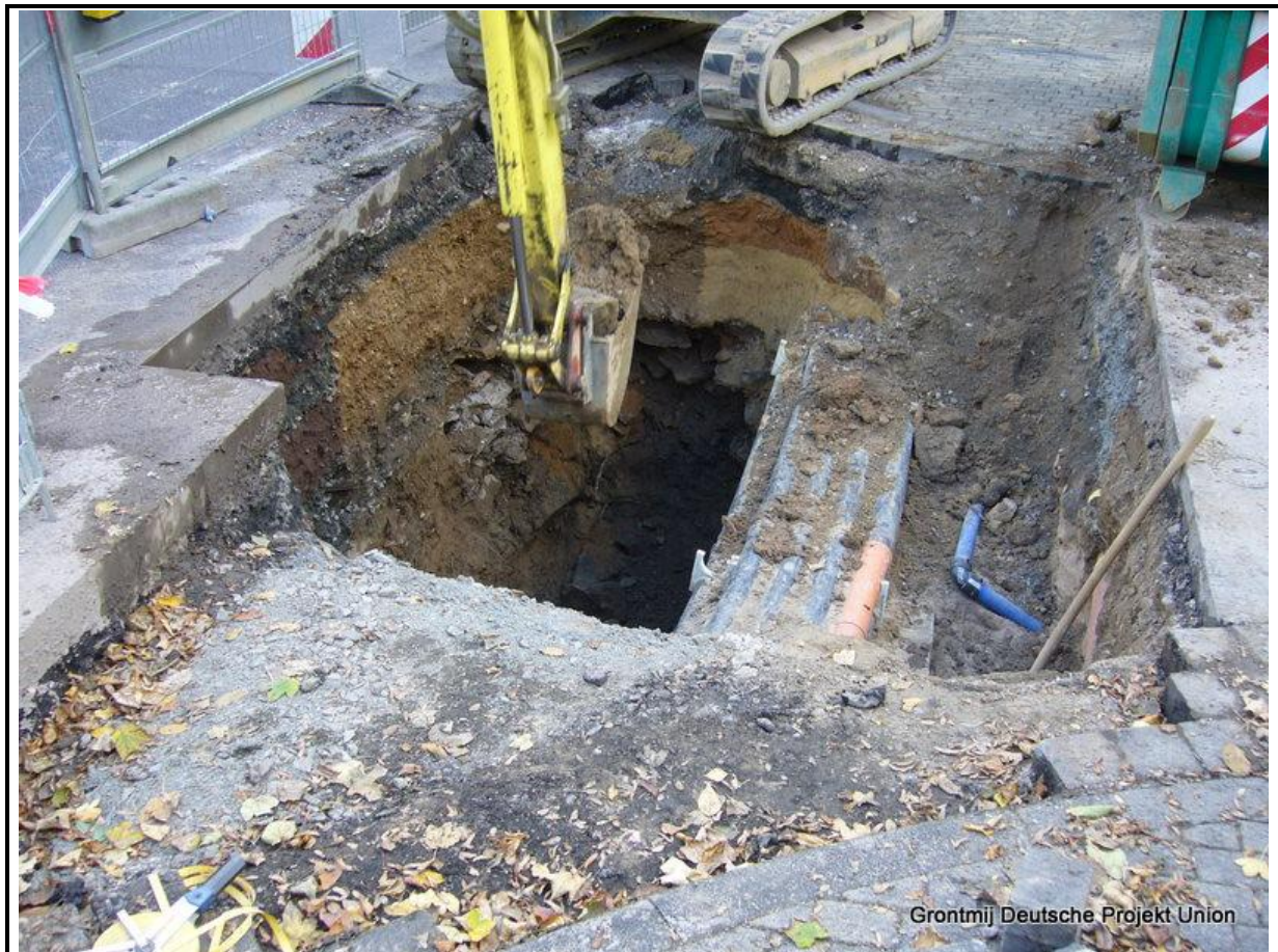
Abb. 5: Ausheben der Baugrube
