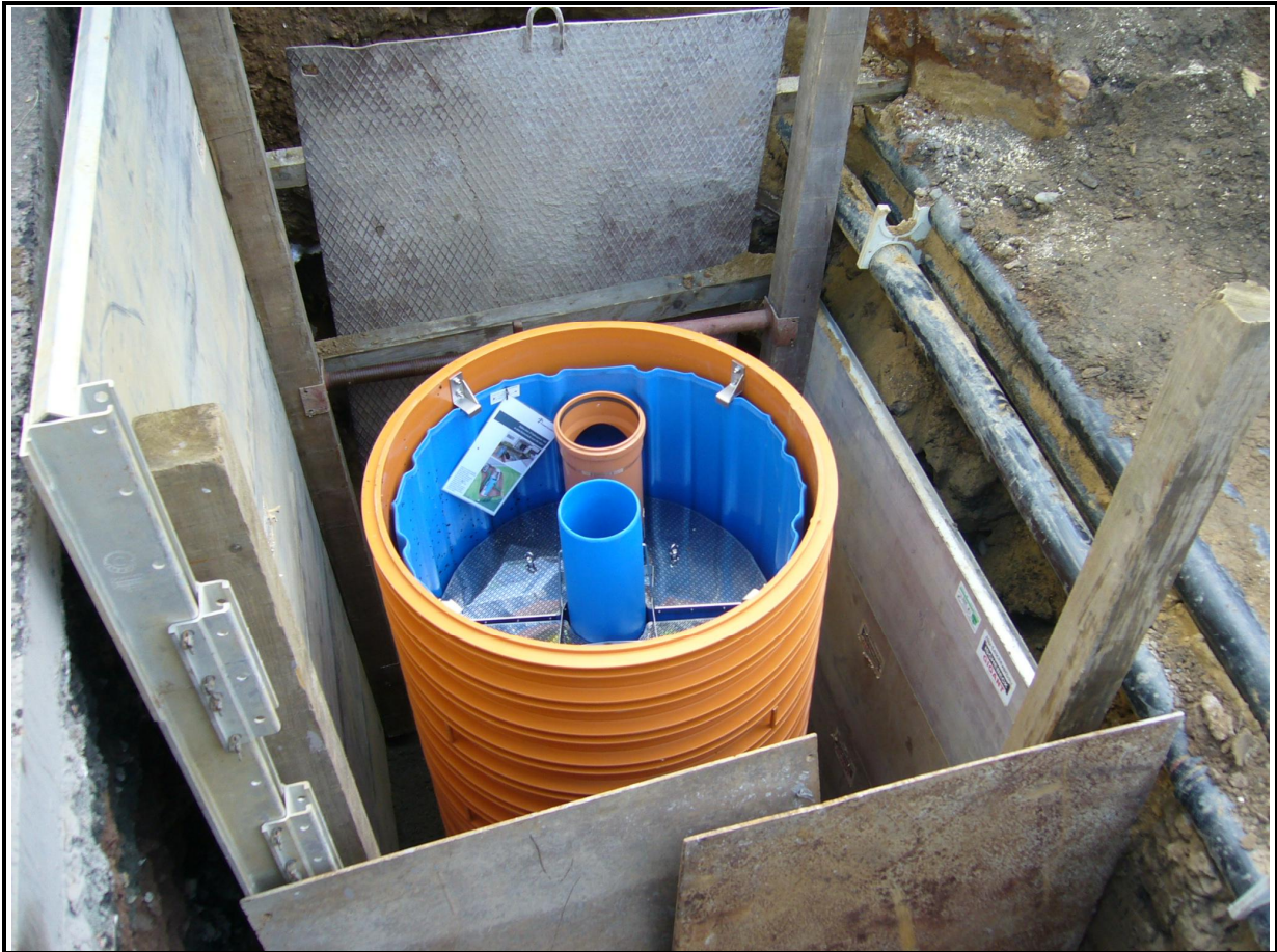
Abb. 6: eingesetzter Filterschacht
