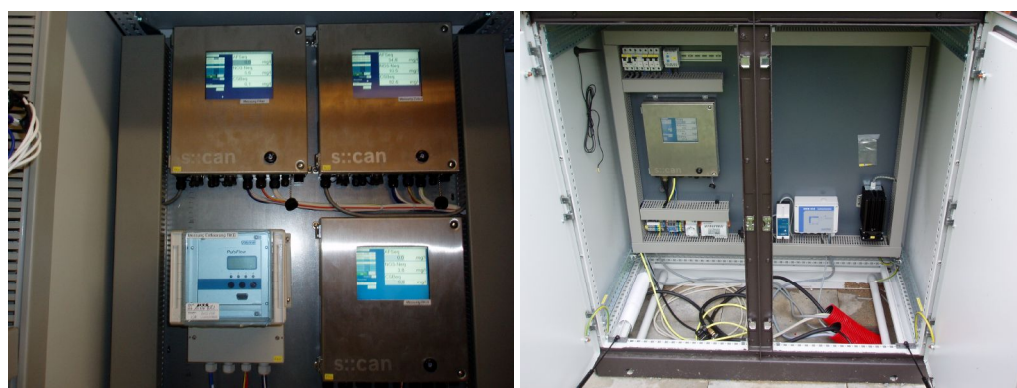
Bild 5 s::can-Bedienrechner der Sonden Zulauf und Ablauf RKB (links) und 3P (rechts)
