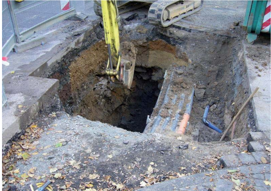
Abb. 2: Ausheben der Baugrube
