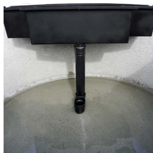
Standsicher durch die Abstützung auf dem Beruhigten Zulauf
