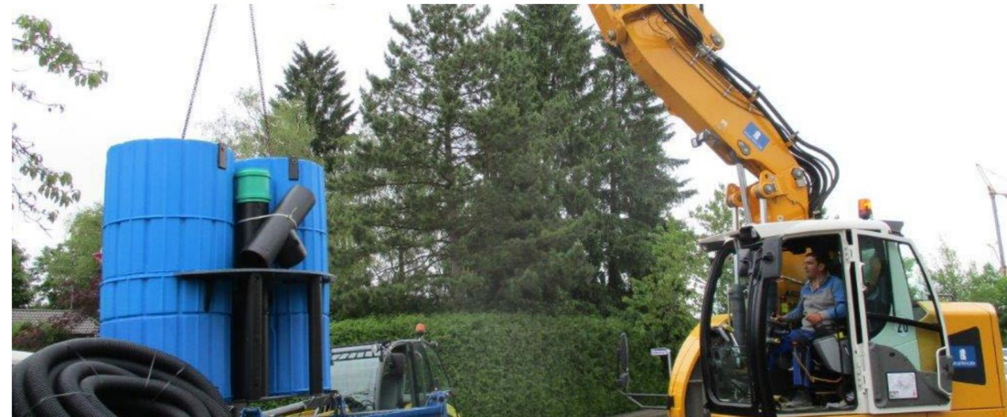
Auf Grund der kompakten Bauweise und den leichten Materialien ist das Versetzen des Systems mit einem Baustellengerät möglich, welches auf jeder Tiefbaustelle vorhanden ist.
