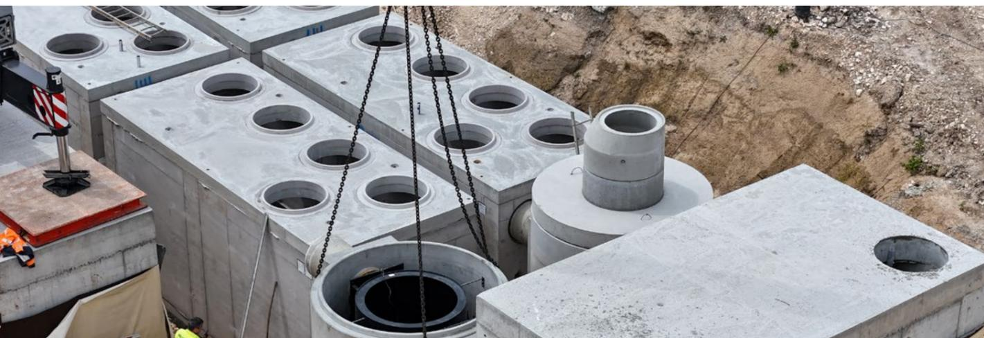
Wasser im Aufstromverfahren sechs Filterelemente, die Feinstoffe ausfiltern und gelöste Schadstoffe adsorptiv binden. Die Sedimentations- und Filteranlagen sind einfach zu warten und zu reinigen. Je Komplettsystem, bestehend aus einer Hydroshark Sedimentationsanlage und zweimal vier Hydrosystem Filtrationsanlagen, kann eine Verkehrsfläche von 15.000 m<sup>2</sup> angeschlossen werden.
