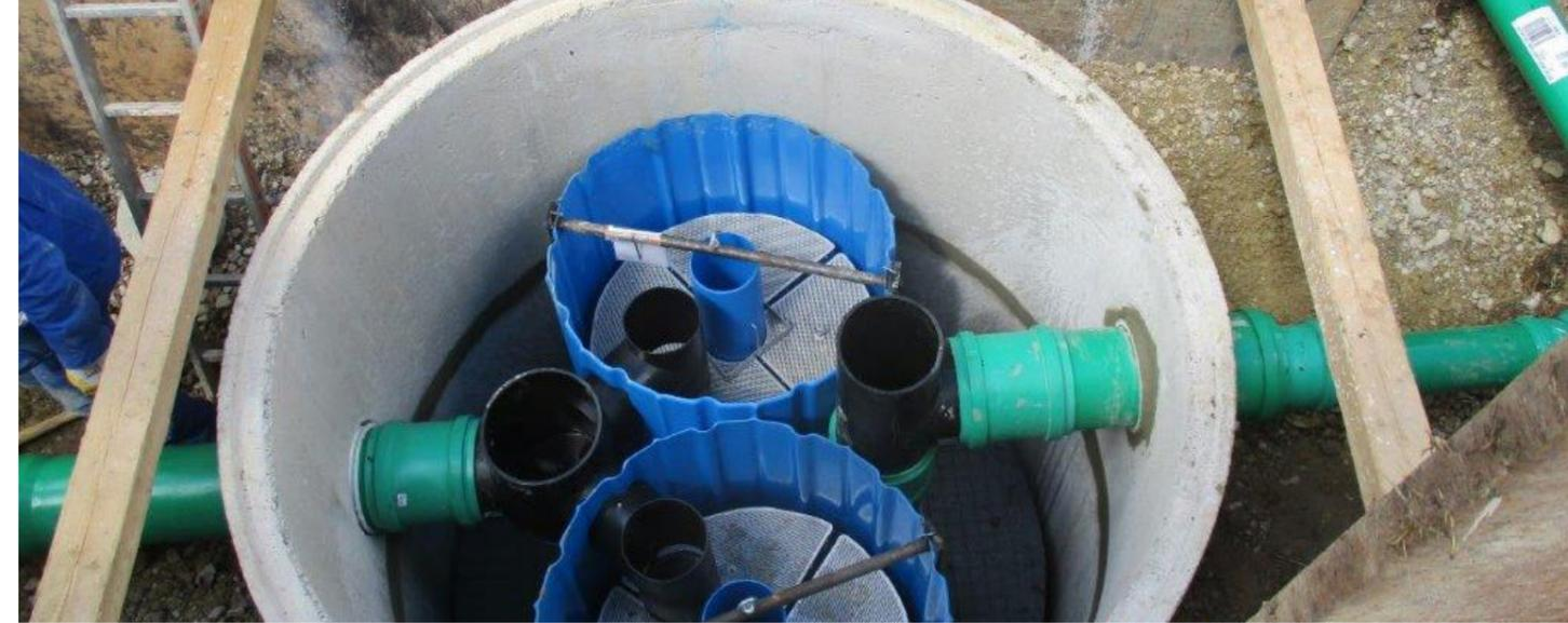
Eingesetzte Behandlungsanlage **Hydrosystem heavy traffic** in der Zwillingversion. Zulauf rechts im Bild, Ablauf entsprechend links, wobei die Winkelverhältnisse variabel sind.
