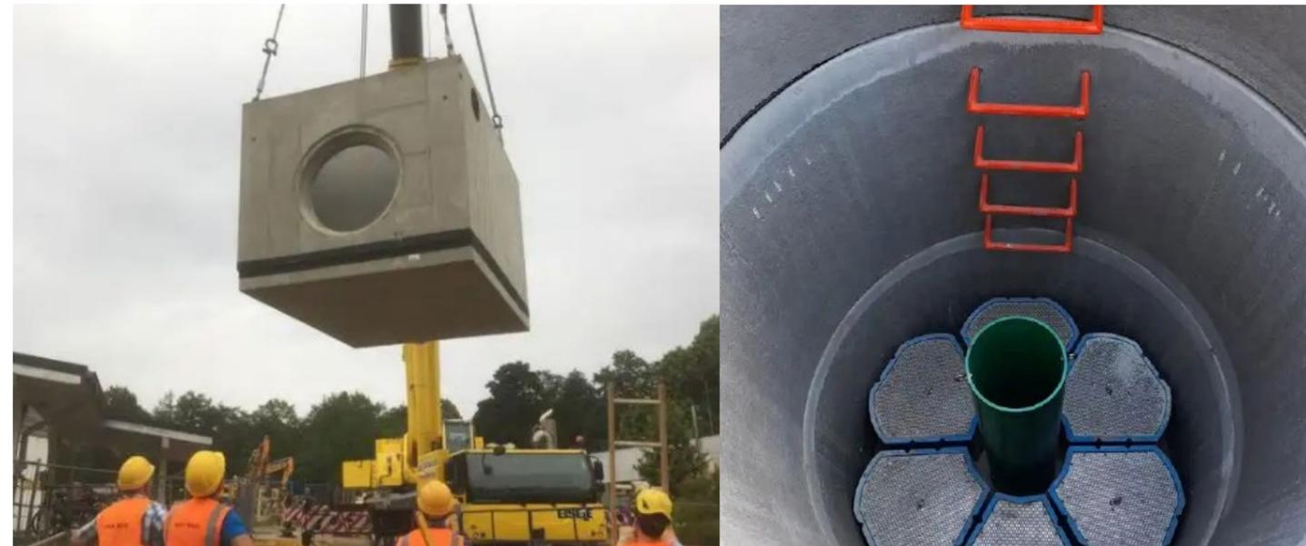
Ca. 45 Tonnen wiegt das Drosselbauwerk, das für einen geregelten Abfluss der Niederschläge sorgt. Foto: Max Bögl
